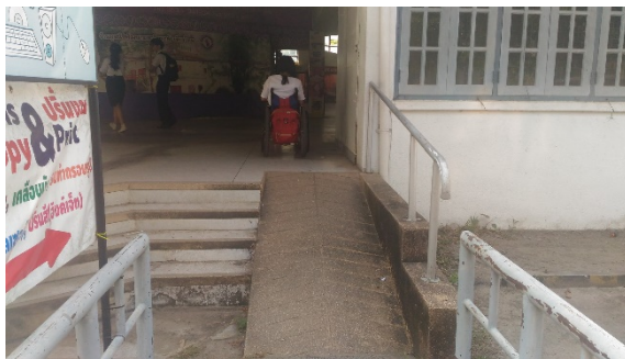
รูปที่ 3 รูปภาพทางลาดที่มีความชันมากเกินไป รถเข็นของนักศึกษาผู้พิการจะสามารถใช้บริการ ได้อย่างสะดวก 10
